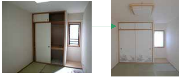
天井、壁のクロスを張替え、畳交換襖、障子の張替えて、雰囲気ががらりと変わりました。
