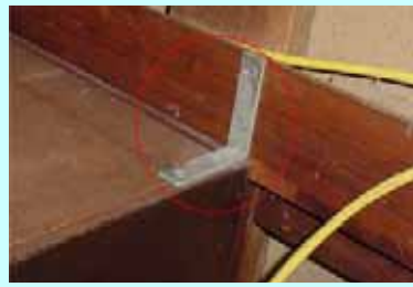
L型金物で家具を柱に固定しています
