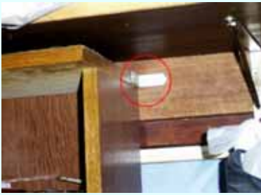
L型金物で家具を柱に固定しています
